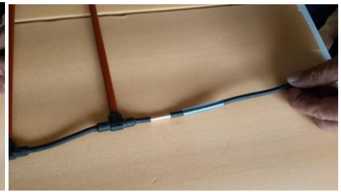
3.Összekötő csatlakozó és zsugorcső
