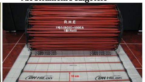
12. A fűtőrács telepítése.
