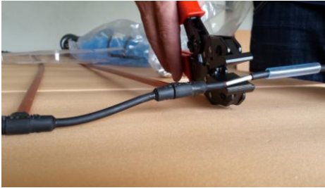
4.A csatlakozó préselése
